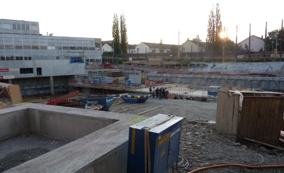
Baustellenbesichtigung am Europaplatz im Anschluss an die Jahresversammlung 2013
